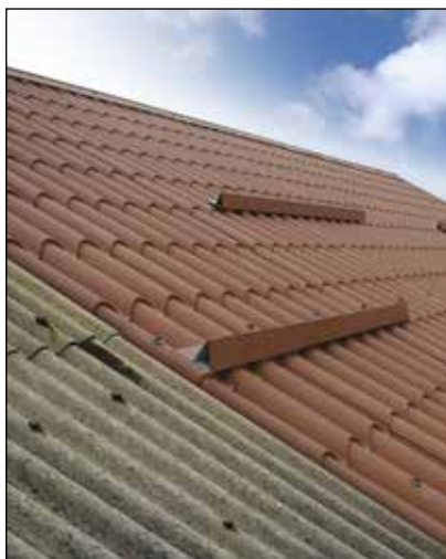
Sostituzione con pannelli
