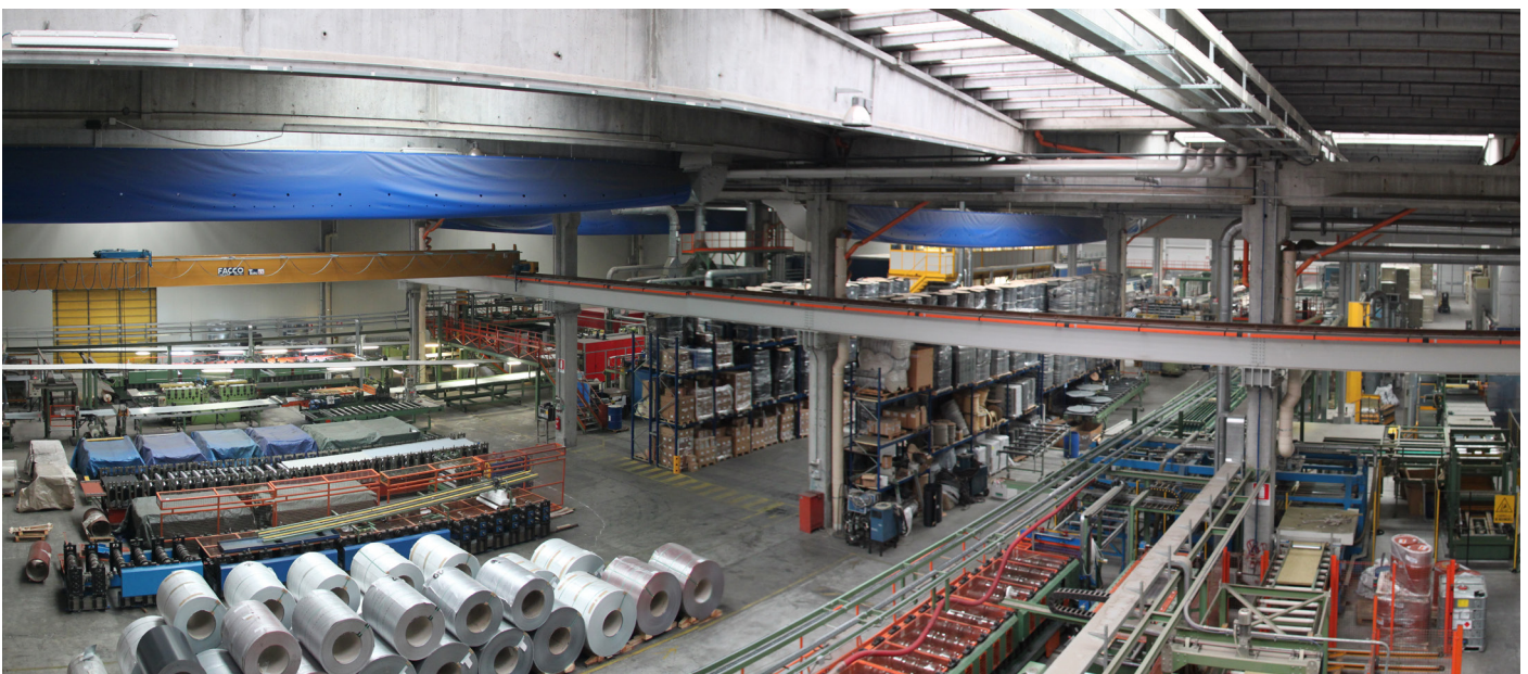
Stabilimento di produzione Isolpack a Nichelino (TO) Isolpack production plant in Nichelino (TO)
